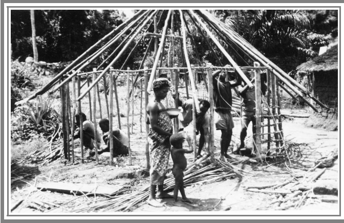
16.6 Tous à l'ouvrage Construction d'une nouvelle case à Boketa
