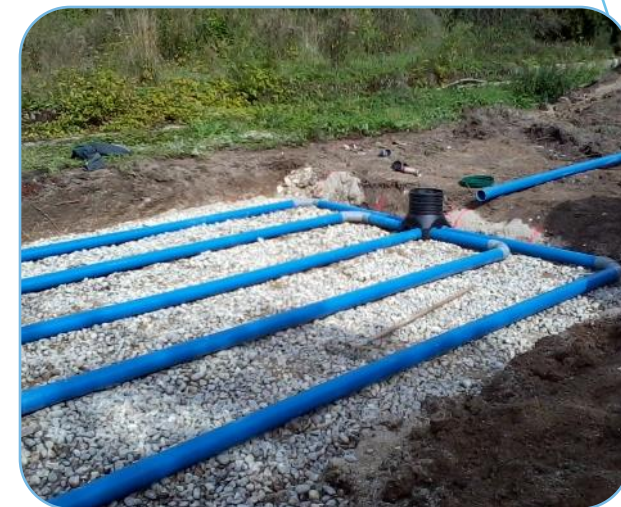
Trop-plein vers drain & massif d'infiltration
