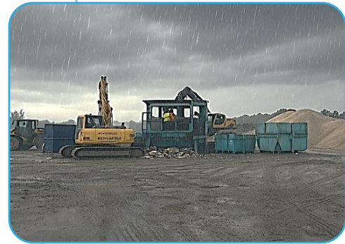
Eau de ruissellement plateforme & trop-plein cuve lavage
