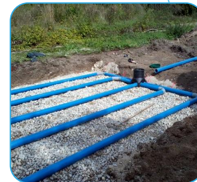
Trop-plein vers drain & massif d'infiltration
